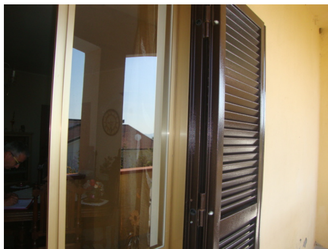
Foto - Particolare infisso
