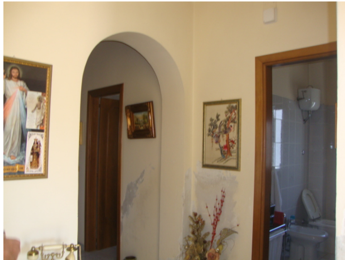
Foto - Corridoio e ingresso bagno
