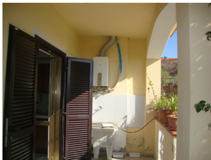
Foto - Balcone coperto lato nord-ovest
