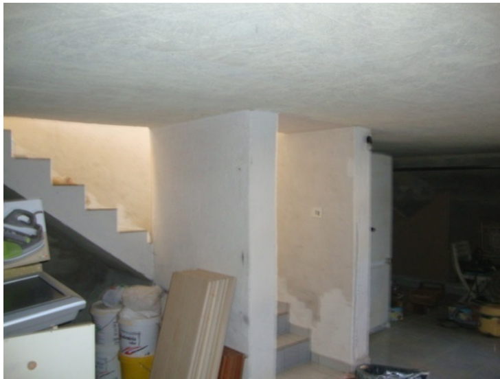
Foto - Locale interrato
