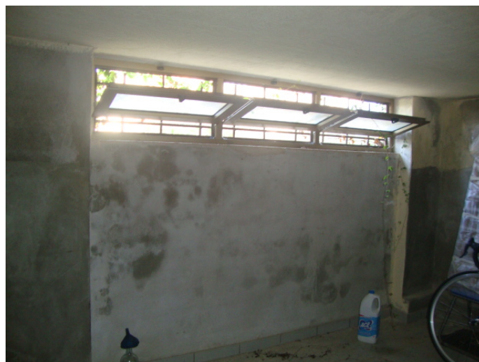
Foto - Locale interrato a nord-est; parete d'accesso al garage chiusa
