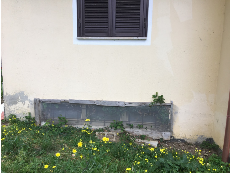
Foto - Parete nord-est, finestrone del locale interrato
