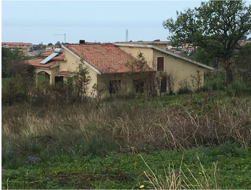
Foto - Vista da nord
