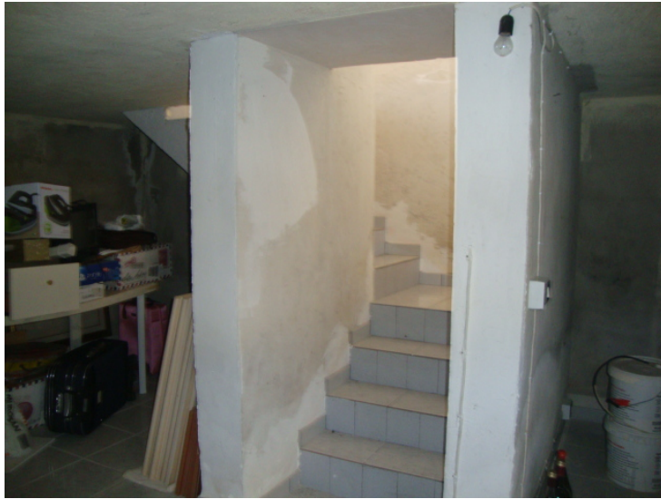
Foto - Locale interrato, scala interna
