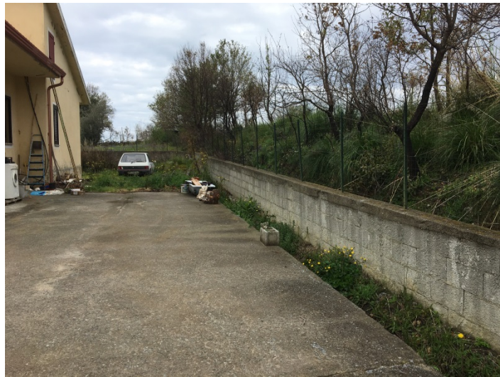
Foto - Lato nord-ovest
