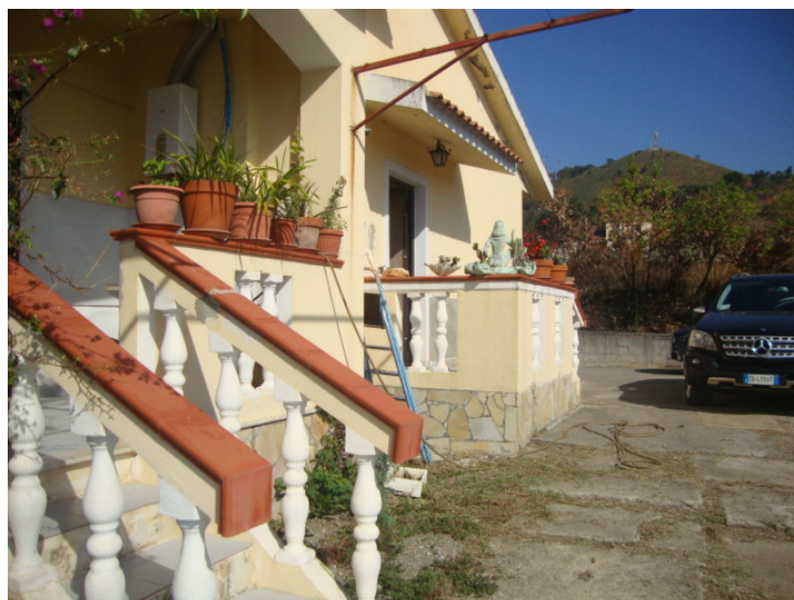
Foto - Lato sud-est
