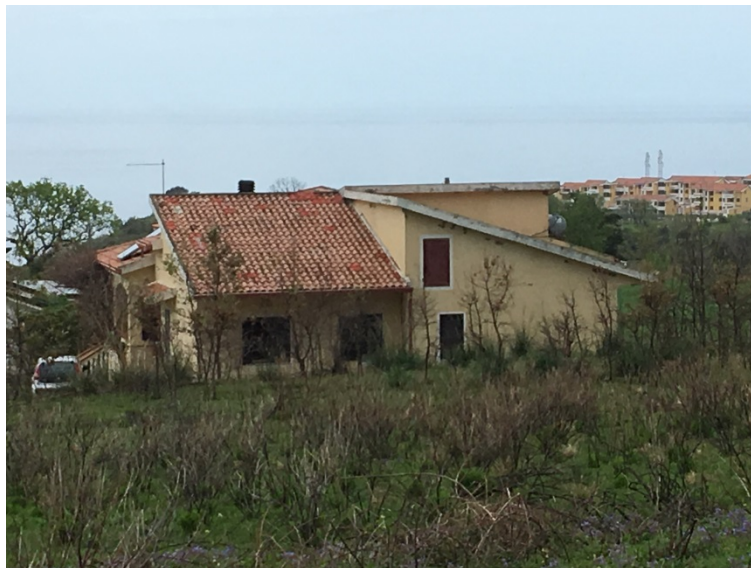
Foto - Vista da nord
