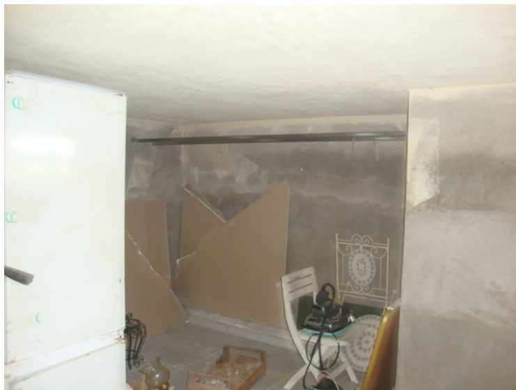
Foto - Locale interrato
