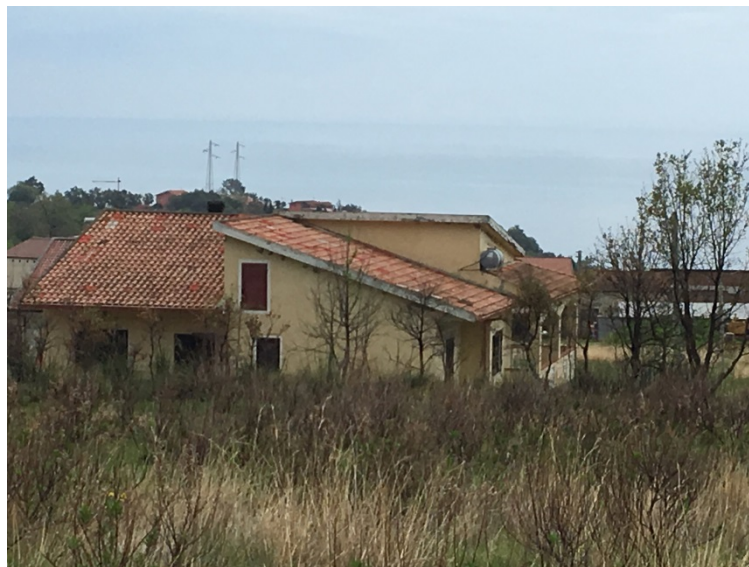
Foto - Vista da nord
