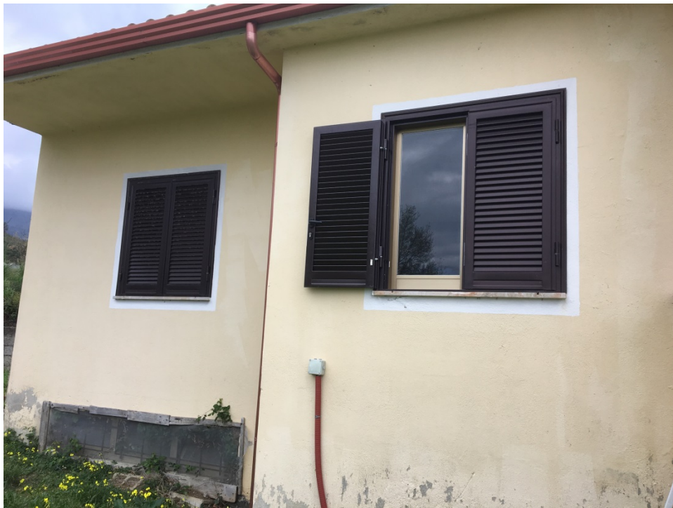
Foto - Parete nord-est, a sinistra finestrone del locale interrato
