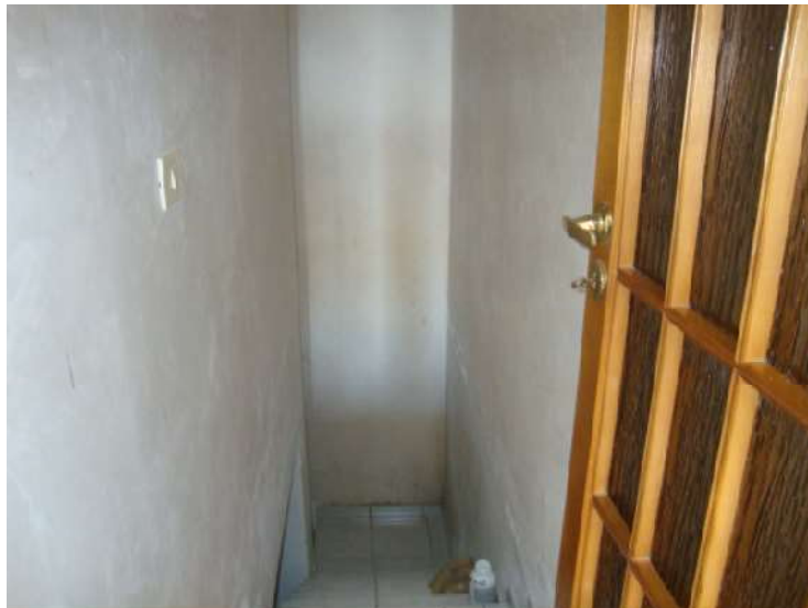
Foto - Scala interna d'accesso al locale interrato
